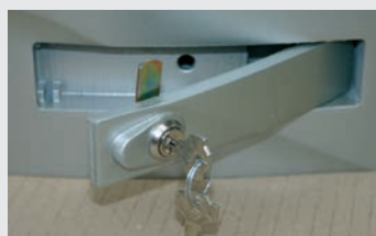
Odblokowanie z metalową dźwignią i zamkiem
